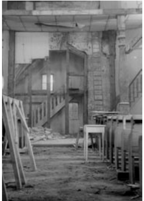
Evangelische Kirche Werdorf von innen während des Umbaus Mitte der Sechziger Jahre
